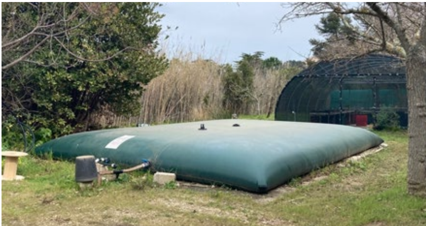
Cisterna esterna per acqua piovana da 50 m 3 (COPAINS, Porquerolles) ©Babou Verhaegen
