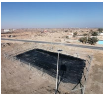
Bassin en construction à El Ayoun sur l'île de Kerkennah, 2022 ©SMILO
