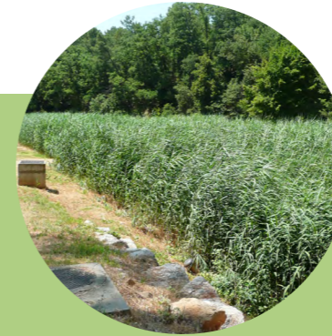
Filters plantés de roseaux/végétaux (à écoulement vertical descendant)
