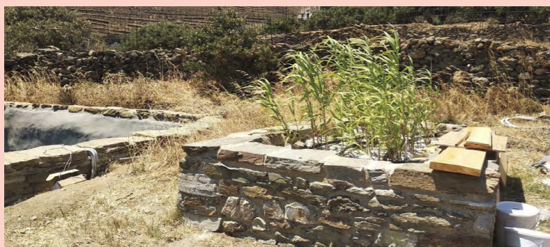
Filtre planté opérationnel
