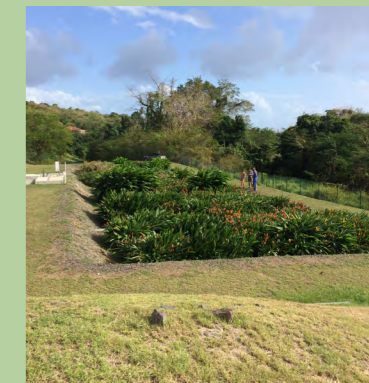
Etage de filtres plantés de végétaux en Martinique (crédit photo INRAE)
