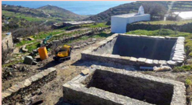
Filtre planté et réservoir d'eaux pluviales en construction
