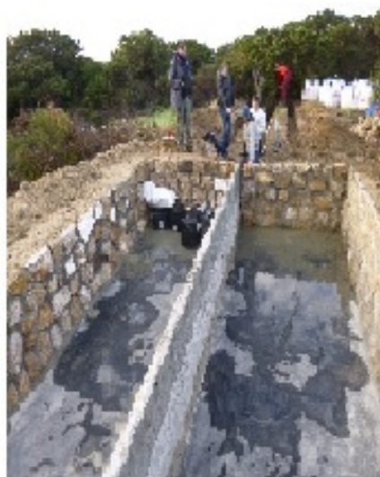
Construction du filtre à sable ( premier plan)
