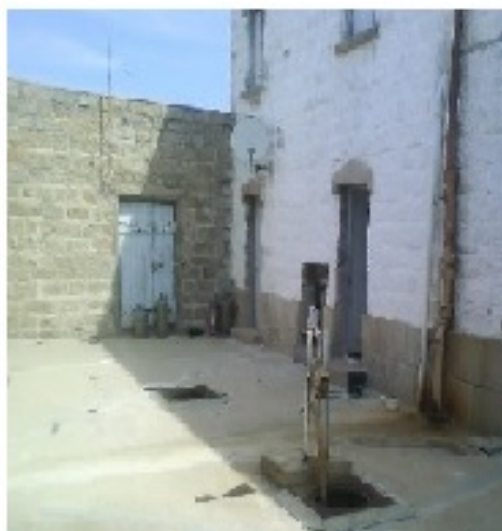
Cour intérieure avec trappe d'accès aux caves historiques
