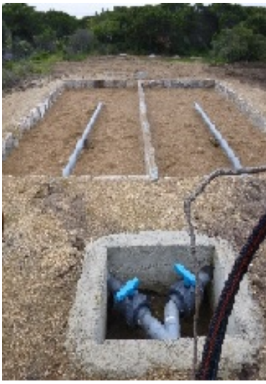
Construction de l'épandage souterrain ( arrière plan)
