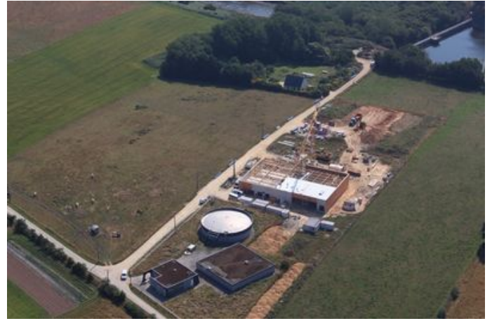
Construction de l'usine de production d'eau potable
