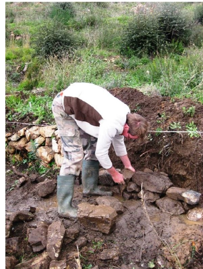
Etape de parement
