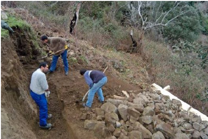
Etapes de déblayage et de fondations
