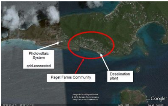
Vue aérienne de la communauté de Paget Farms montrant approximativement les emplacements de l'usine
