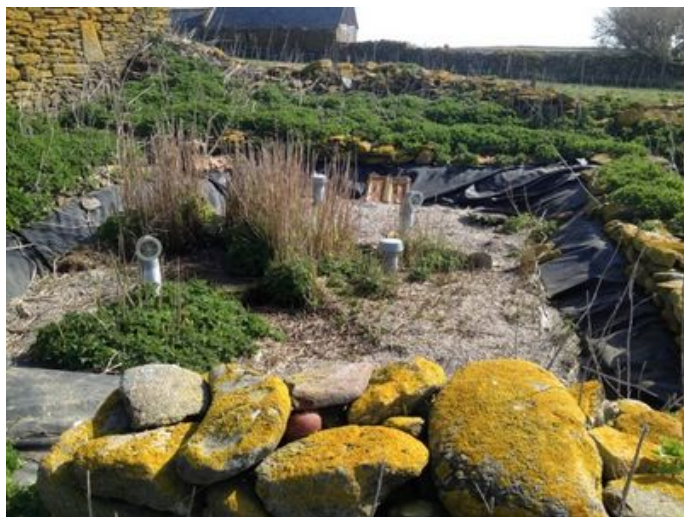
1er étage des filtres plantés aux Marais du Vigueirat
