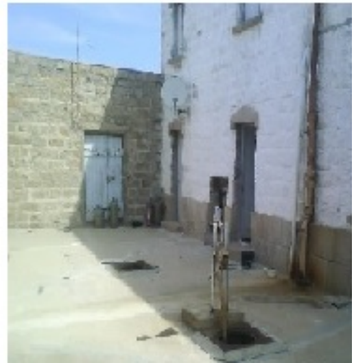
Corte interna con la botola di accesso alle vasche
