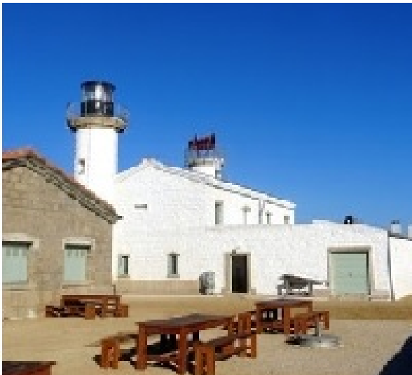
Corte esterna sopra la nuova vasca di stoccaggio dell'acqua piovana (sportello di chiusura visibile)
