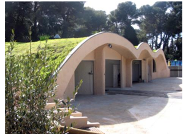
Quai de transfert des déchets sur l'île
